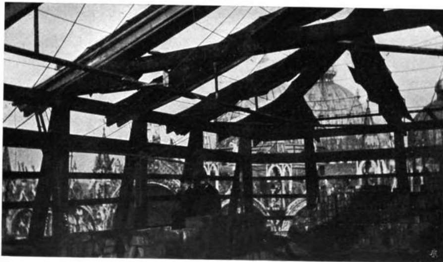
Il lavoro sotto la protezione dell'armatura mobile.
