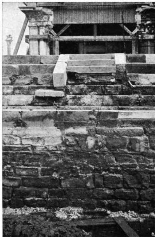
Fig. II — La scala d'accesso al Campanile e la sottostante lesione — Marzo 1903.
