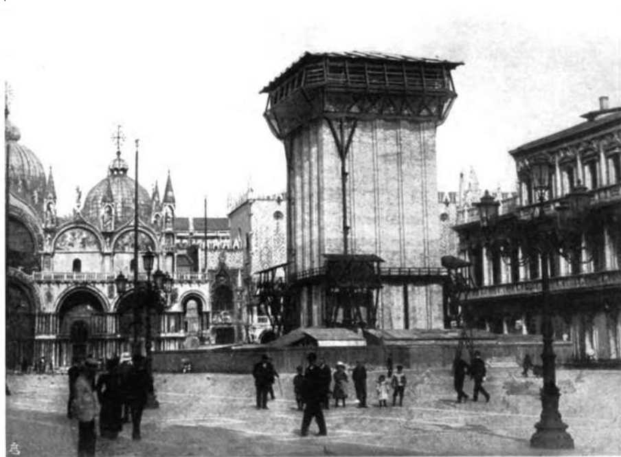
La ricostruzione: l'armatura mobile.
