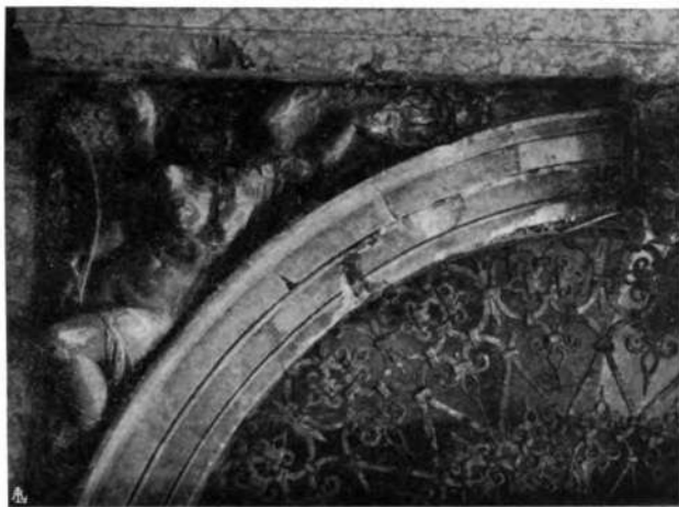
Porzione ricomposta di una vecchia arcata.
