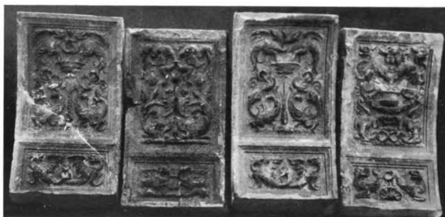
Formelle degli intradossi delle arcate riposte in opera nelle nuove strutture.
