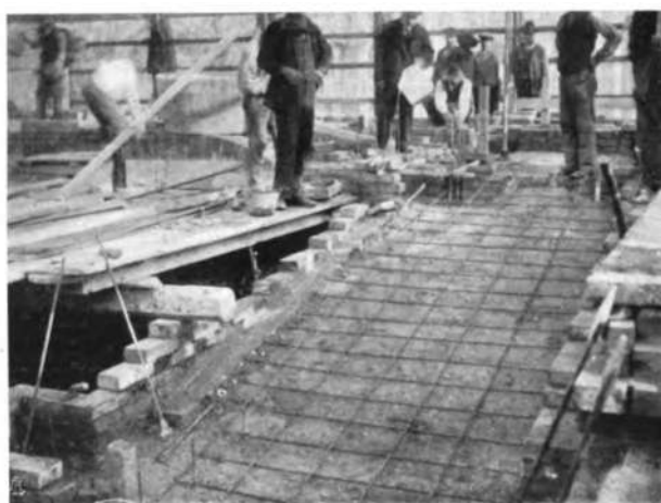
La struttura in cemento armato delle rampe.
