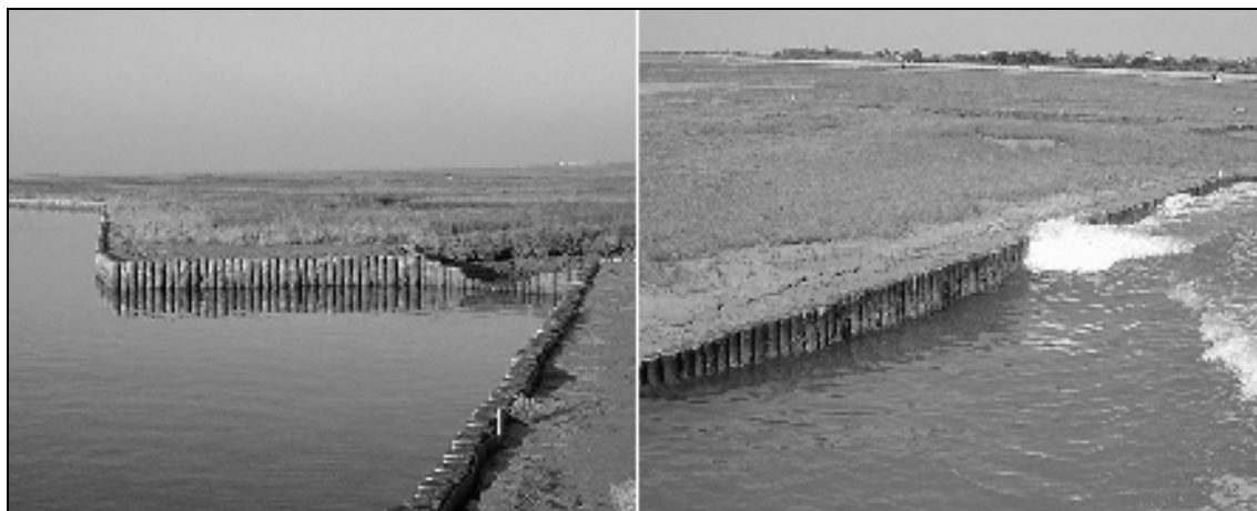
Figura 71 - Moderna palificata di conterminazione. La guaina sistemata tra i pali e i fanghi di colmata, per evitarne l'erosione, ricorda da vicino l'uso dello "strame" nella bonifica per colmata dell'ex cinema San Marco (foto archivio Magistrato alle Acque).
